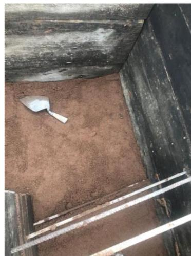
Figura 25. Colocación de la primera capa de tierra. Fuente: Elaboración propia.
