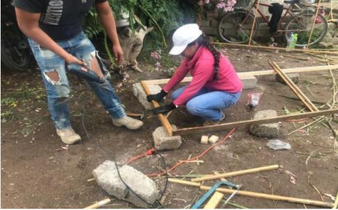
Figura 28. Armado de bastidor para bajareque. Fuente: Elaboración propia.
