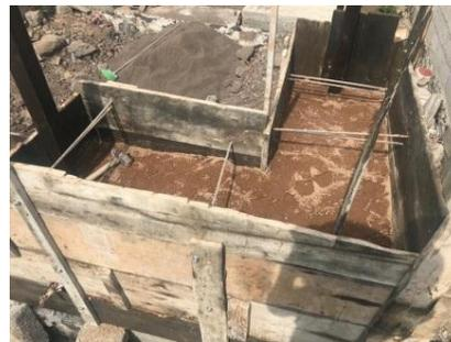
Figura 22. Colocación y nivelación de los tensores. Fuente: Elaboración propia.
