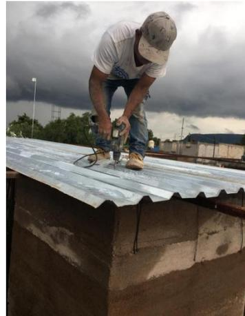
Figura 36. Integración de cubierta de láminas. Fuente: Elaboración propia.
