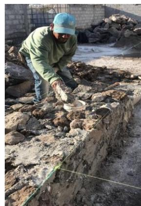
Figura 16. Nivelación de la cimentación ciclópea. Fuente: Elaboración propia.
