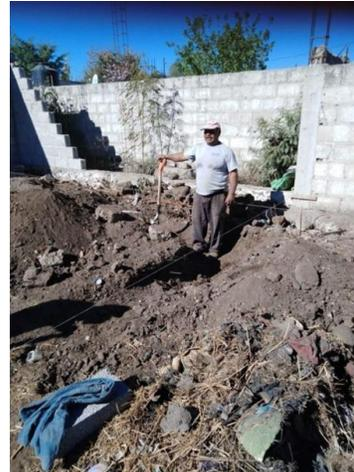
Figura 9. Tendido de hilo para la nivelación del terreno. Fuente: Elaboración propia.
