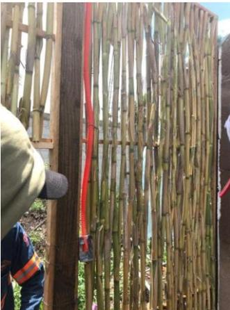
Figura 31. Inserción de instalación eléctrica. Fuente: Elaboración propia.
