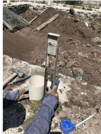
Figura 15. Nivelación de la placa base. Fuente: Elaboración propia.
