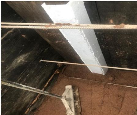
Figura 26. Vertido y apisonado de tierra para el tapial; así mismo el recubrimiento del polín con unicel. Fuente: Elaboración propia.
