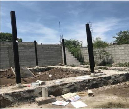
Figura 19. Ajuste de polines en la palca base. Fuente: Elaboración propia.
