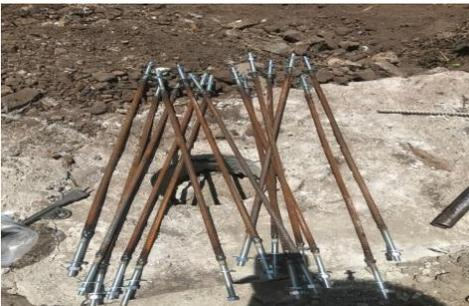
Figura 20. Armado de tensores. Fuente: Elaboración propia.
