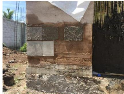
Figura 34. Pruebas para el aplanado del tapial. Fuente: Elaboración propia.
