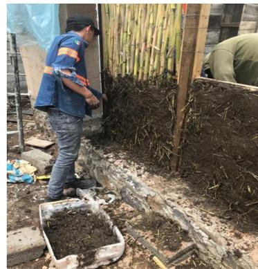
Figura 32. Integración de mezcla en el entramado para el bajareque. Fuente: Elaboración propia.
