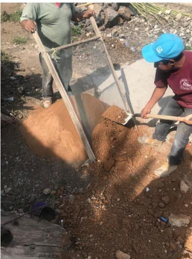
Figura 23. Limpieza de la tierra para el tapial. Fuente: Elaboración propia.
