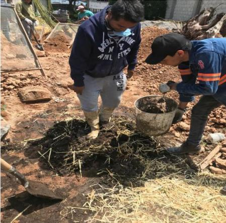
Figura 30. Preparado de mezcla de tierra con paja para el bajareque. Fuente: Elaboración propia.
