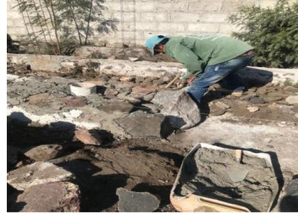
Figura 13. Colocación de piedras para cimentación ciclópea. Fuente: Elaboración propia.
