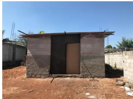
Figura 37. Integración de cubierta de láminas. Fuente: Elaboración propia.
