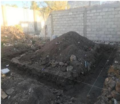
Figura 10. Excavación de zanja para la cimentación. Fuente: Elaboración propia.
