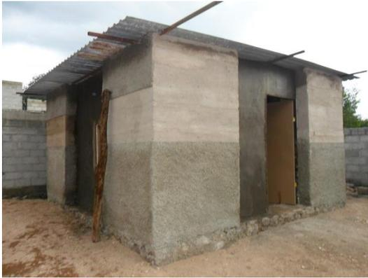
Figura 39. Integración de cubierta de láminas. Fuente: Elaboración propia.
