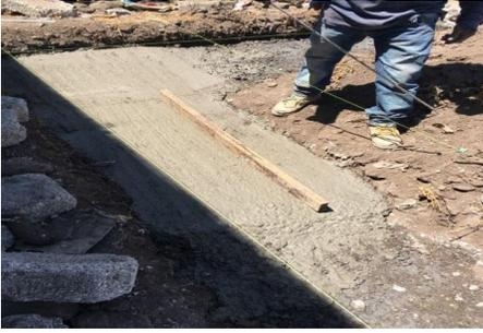
Figura 12. Placa de cemento para cimentación. Fuente: Elaboración propia.
