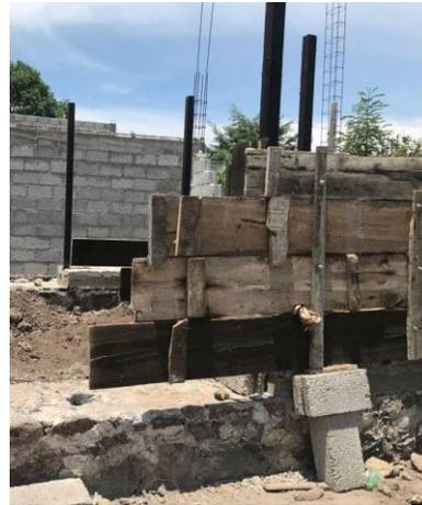
Figura 21. Colocación de cimbra para tapial. Fuente: Elaboración propia.
